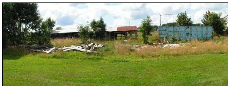
Figure 4 : Déchets et bâtiment délabré constatés sur le site d’étude (source : CSD).
