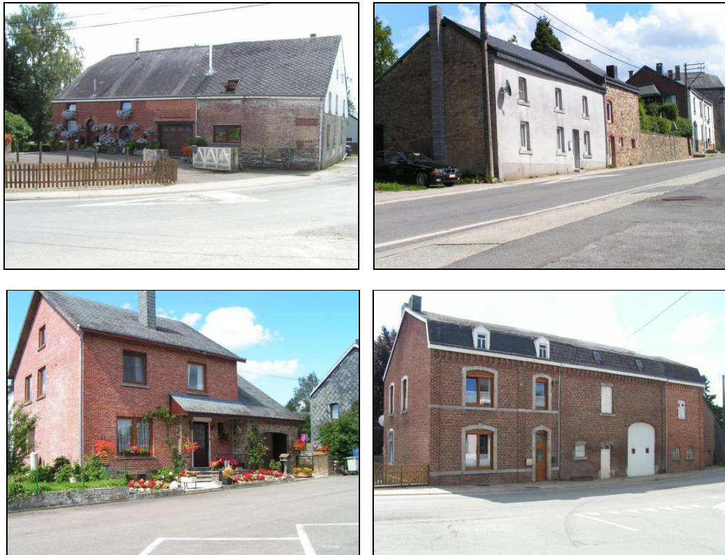
Figure 24 : Habitat traditionnel développé dans le centre de Champlon (source : CSD).
