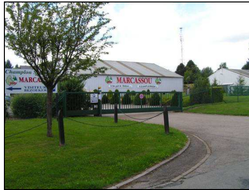
Figure 26 : Usine Marcassou (source : CSD).
